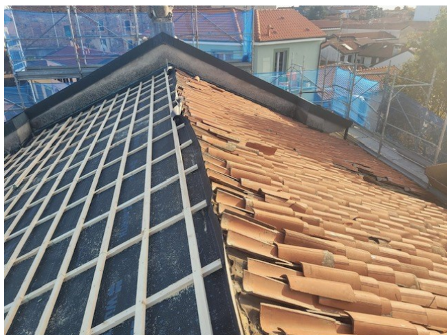
POSIZIONAMENTO LISTELLI LIGNEI E TELO VAPORE
