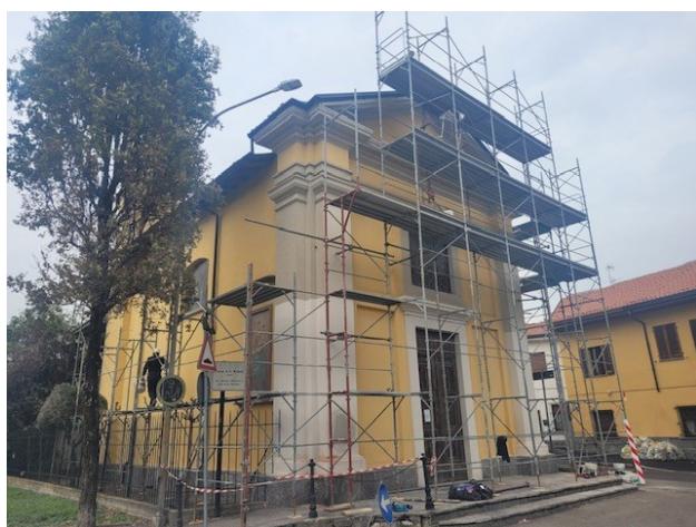
PONTEGGIO PER SICUREZZA
